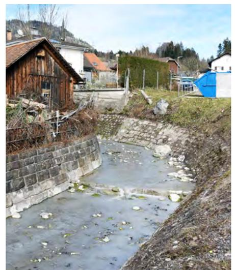
Störender Bewuchs im Dorfbach wurde entfernt, der Abfluss ist also auch bei hohem Wasserstand ungehindert möglich.
