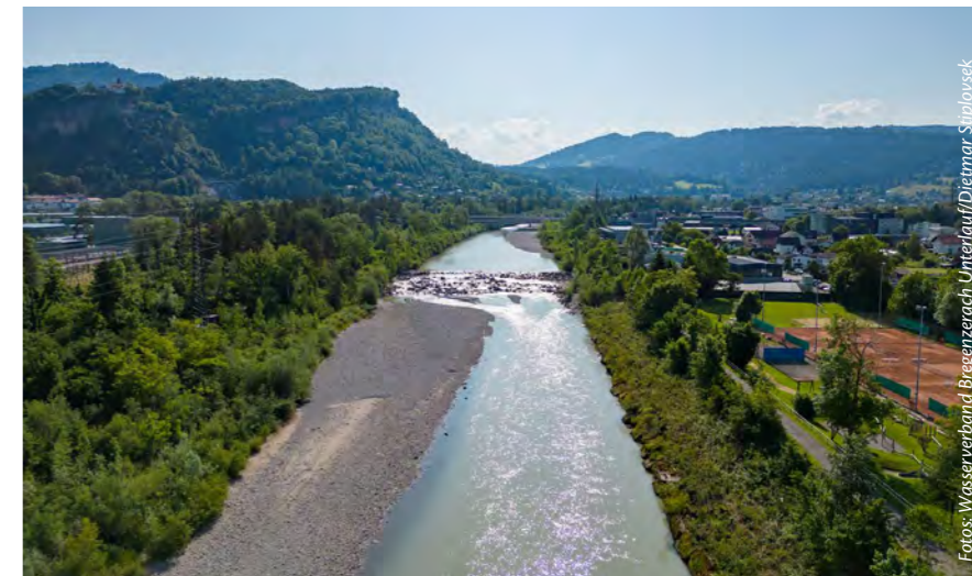
Blick von der Brücke in Lauterach auf den neuen Bauabschnitt Richtung Kennelbach
