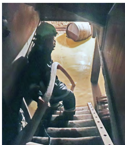
Überflutete Keller und Schlammflut in der Telle.
