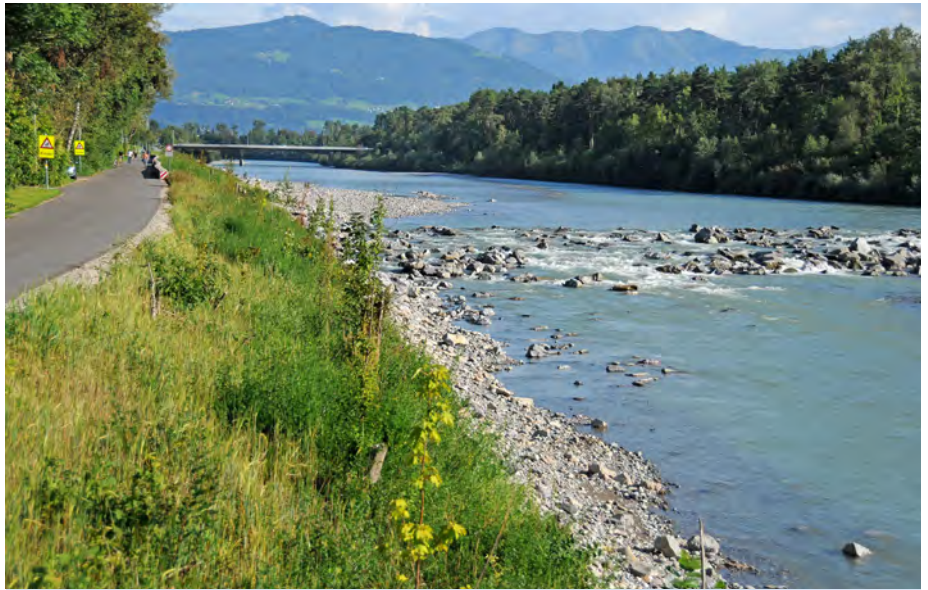
Das Bregenzer Achufer ist schon wieder begrünt. Am Harder Ufer gegenüber wird der Damm 30 m weit landeinwärts verlegt.
